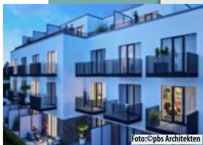
Foto: ©pbs Architekten
