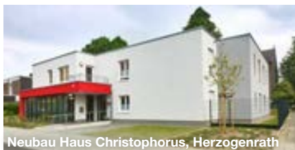
Neubau Haus Christophorus, Herzogenrath
